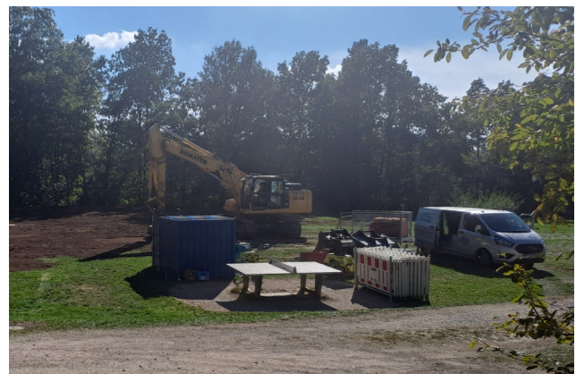
Abbildung 31: Eine vollbiologische Kleinkläranlage wurde am Rande des Zeltplatzes eingebaut.
